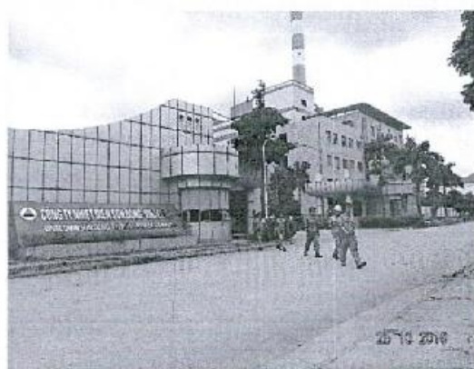
Hình 4: Nhà máy Nhiệt điện Sơn Động
