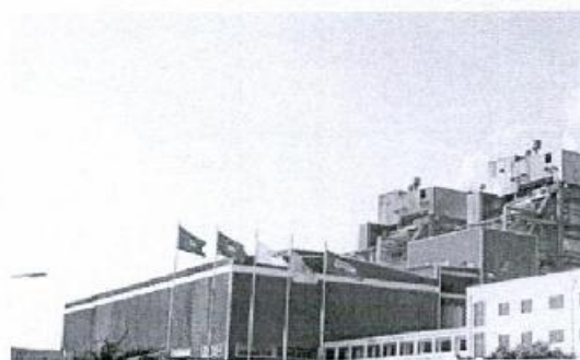
Hình 3: Nhà máy Nhiệt điện Cao Ngạn
