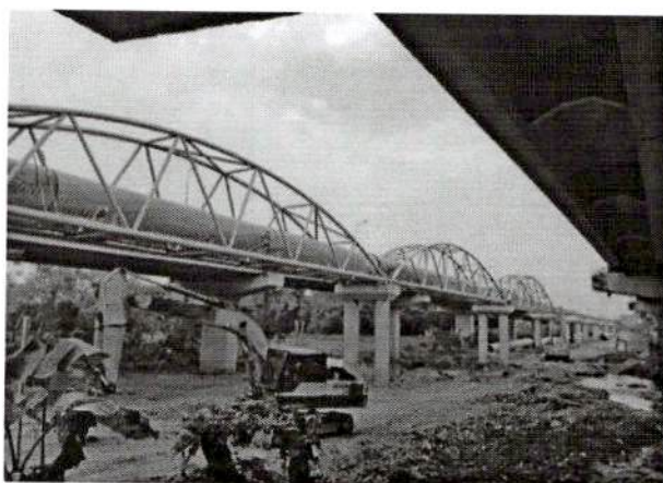
Hình ảnh 1: Thi công lắp đặt dàn thép đỡ ống DN 1800 dài 262,4 m qua sông Đáy
