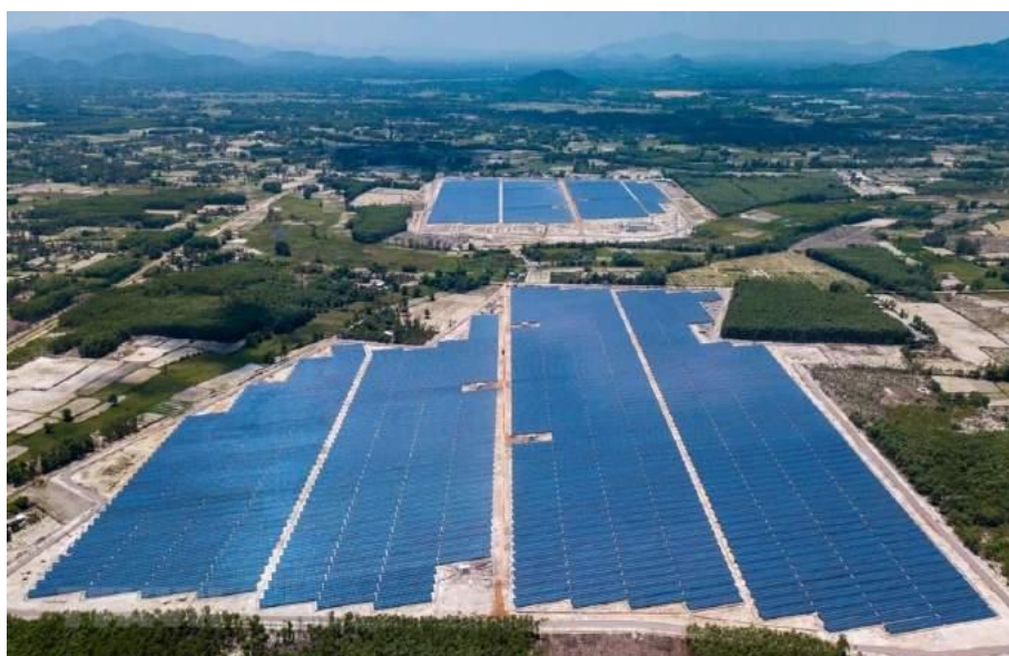
Hình 6: Nhà máy điện mặt trời Cát Hiệp
