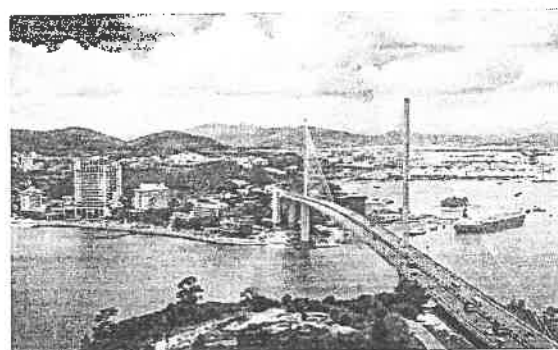
Cầu Bãi Cháy
