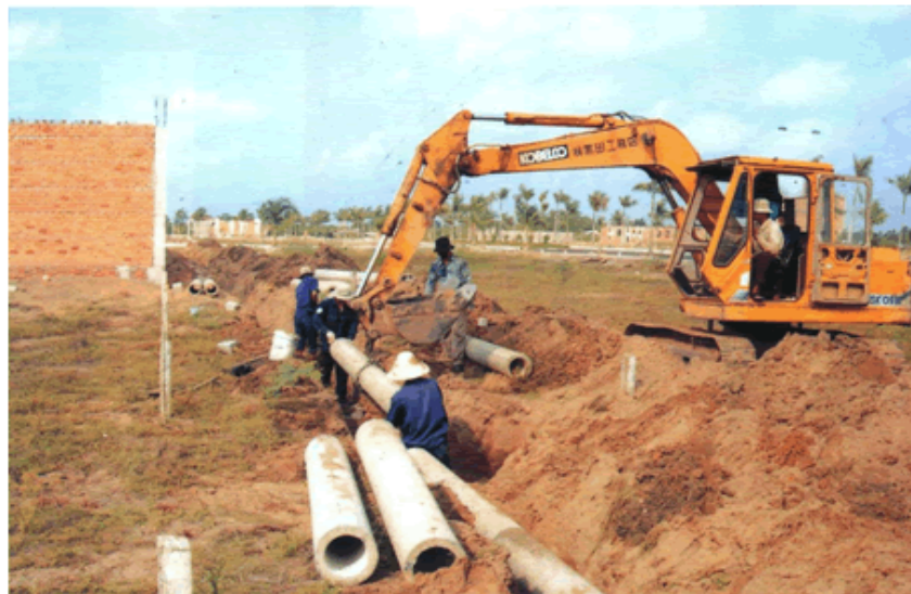
Thi công hệ thống thoát nước
